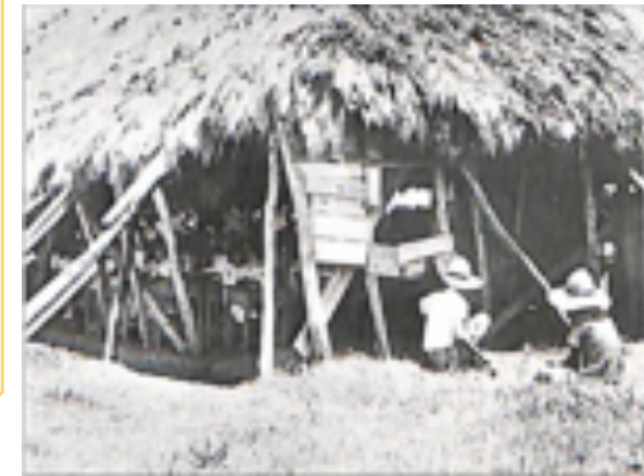
台風で倒壊したのを継ぎ接ぎ支柱で支える。
